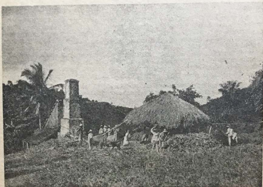
FIG. 50. — Moulin à rolls verticaux d'une petite distillerie agricole (Martinique 1922)
